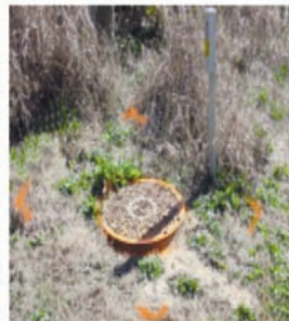
Marcas del Perímetro de Bocas de Inspección/ Acceso
