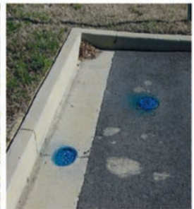
Marcas de Tapas de Cajas de Válvulas
